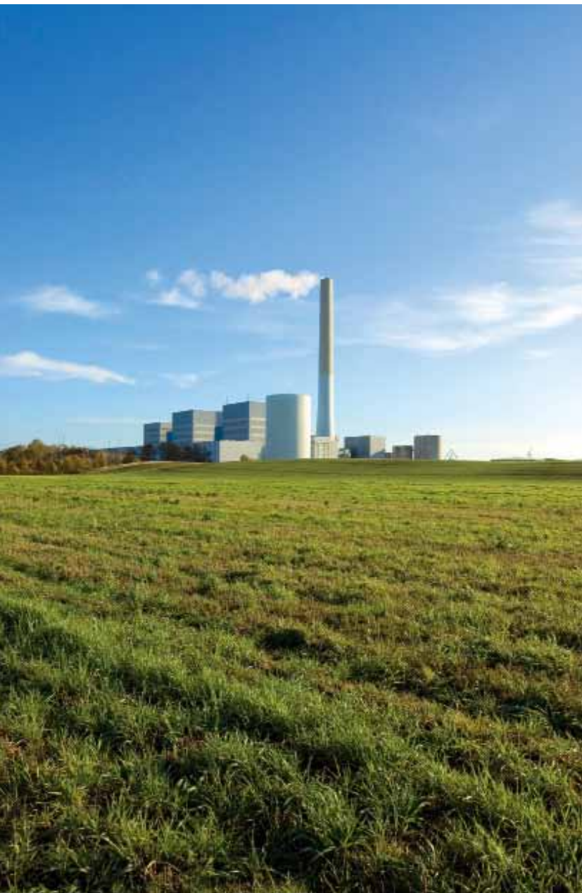
Studstrupværket står for den primære varmforsyning i Århus
