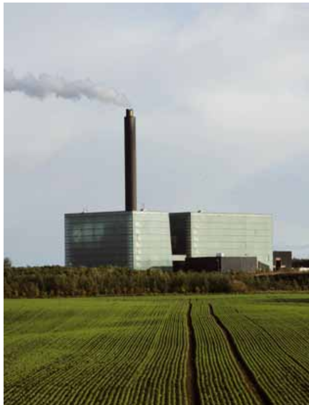
Forbrændingsanlægget i Lisbjerg er ombygget, så man nu kan udnytte en del af varmen i røggassen, som ellers bare ville forsvinde ud af skorstenen
